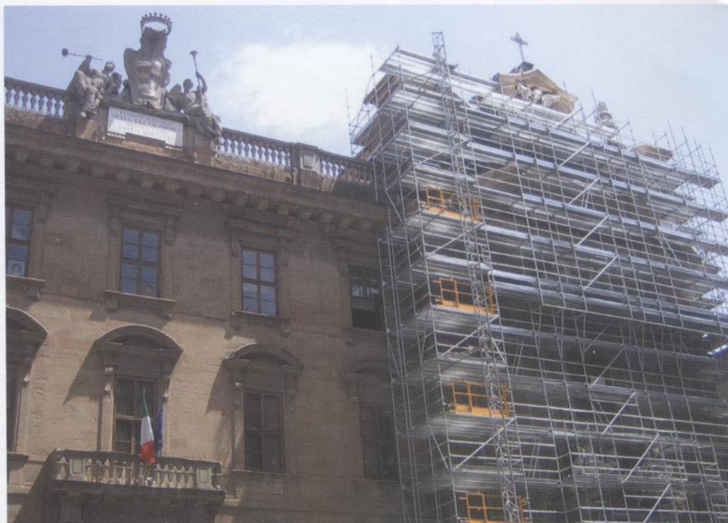
Per restaurare la facciata del Tribunale di Firenze è stato noleggiato il ponteggio multidirezionale Multicom della Condor. L'azienda ha fornito la propria consulenza per progettare la struttura dell'impalcato.
