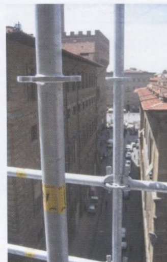
Per restaurare la facciata del Tribunale di Firenze è stato noleggiato il ponteggio multidirezionale Multicom della Condor. L'azienda ha fornito la propria consulenza per progettare la struttura dell'impalcato.
