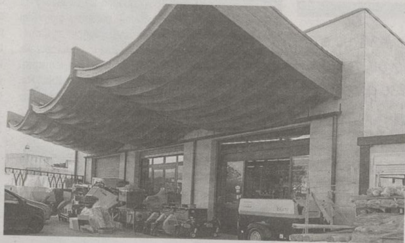
Il punto Edilagro a Castel San Giorgio
