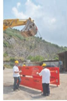
Il blindaggio è un'opera provvisoria con lo scopo di sostenere le pareti dello scavo all'interno del quale si svolgono lavorazioni relative a opere fognarie e condutture di vario genere.
