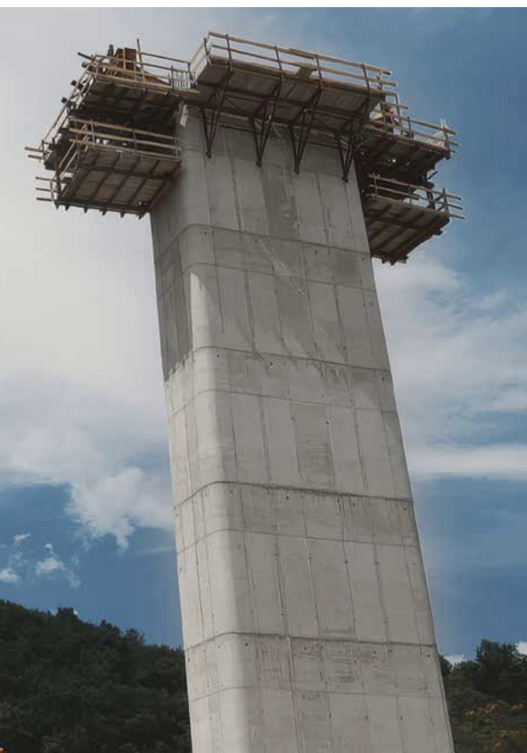
SRC-240 e Cassaforma per pareti Comax S.S. Lioni-Grottaminarda (Italia)
