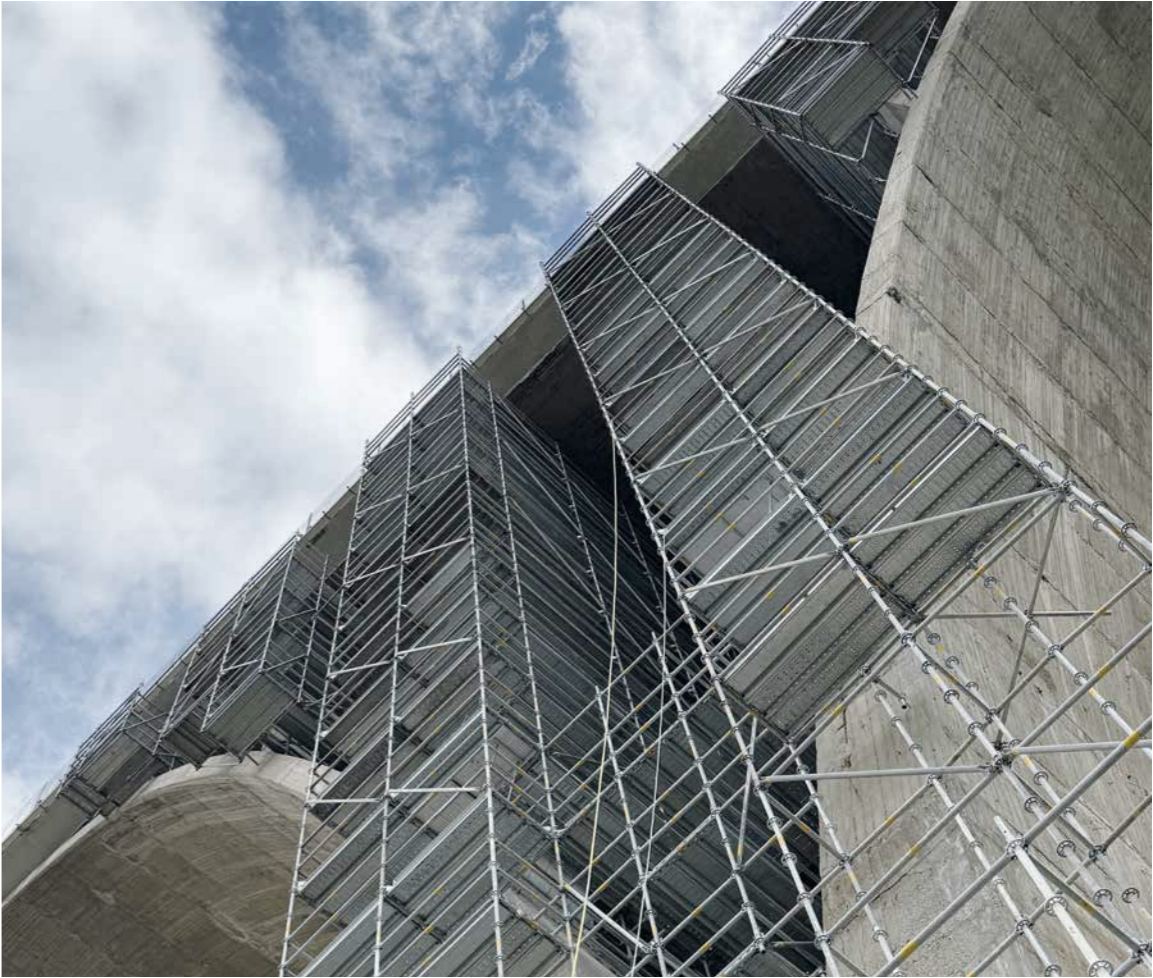
Ponteggio Multicom Manutenzione Viadotto Cava Leone Reggio Calabria (Italia)
