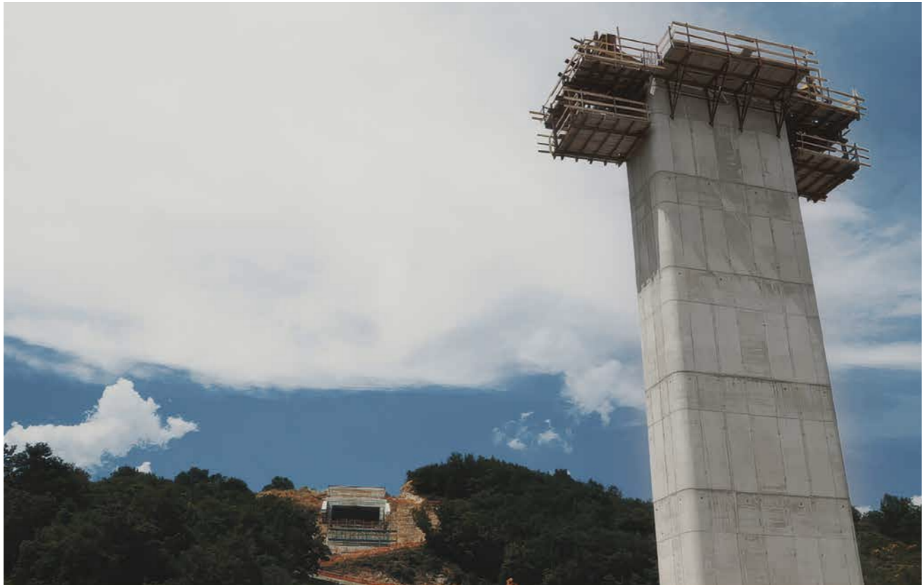
SRC-240 e Cassaforma per pareti Comax S.S. Lioni-Grottaminarda (Italia)
