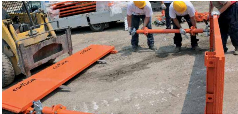
Assemblaggio soprizzo per blindaggio autoaffondante Riser assembly for self-sinking liner Assemblage de la surhausse pour blindage lourd
