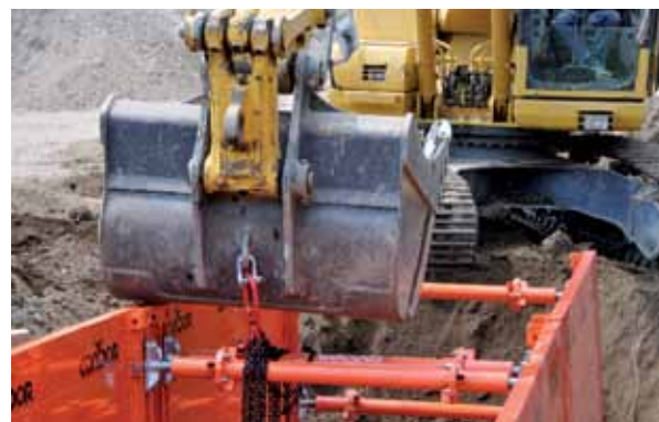
Pressione della benna sui due lati del blindaggio autoaffondante in modo alternato Alternately pushing the bucket on both sides of the self-sinking liner Enfoncement du godet sur les deux côtés du blindage lourd en alternance
