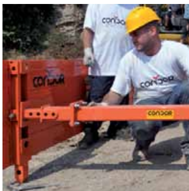
Montaggio distanziale regolabile MF e prolunga Assembly MF - Adjustable spacer and extension Montage entretoise réglable MF et rallonge
