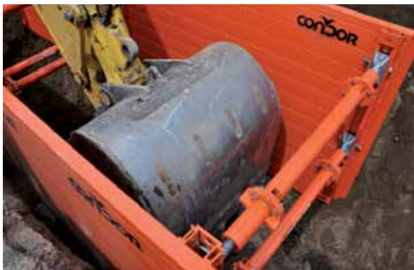
Scavo con l'uso della benna all'interno dei distanziali Excavation using the bucket inside the spacers Fouille avec l'utilisation du godet à l'intérieur des entretoises
